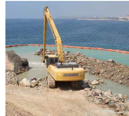
Control del dragado y turbidez generada
