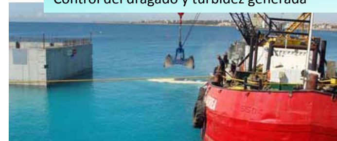
Control del dragado y turbidez generada
