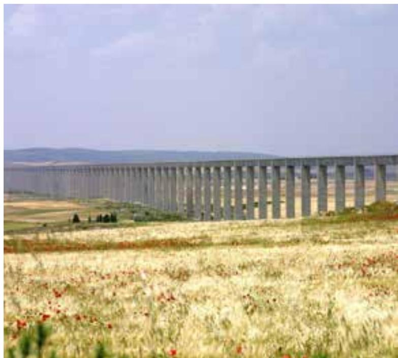
Con el objetivo de evitar la sobreexplotación del acuífero de la Mancha-Oriental, fuente de abastecimiento de Albacete, se ha construido una toma en el acueducto Tajo-Segura con capacidad para 1 m<sup>3</sup>/s de aguas procedentes del río Júcar, y mediante una conducción de 13 km de longitud aproximadamente, se transporta el agua hasta la ETAP de Albacete, situada junto a los depósitos de Cabecera de distribución de agua a la ciudad.
