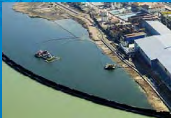
Trabajos de dragado de lodos
