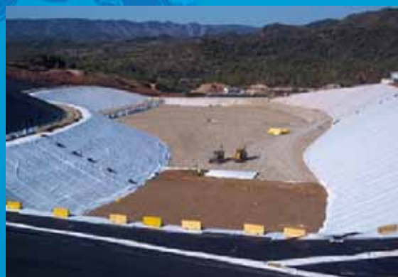
Acondicionamiento del vertedero para el depósito controlado de lodos
