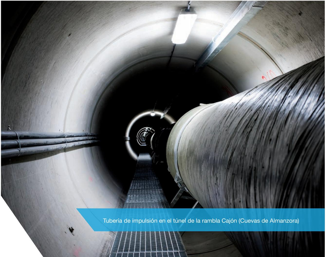
Tubería de impulsión en el túnel de la rambla Cajón (Cuevas de Almanzora)
