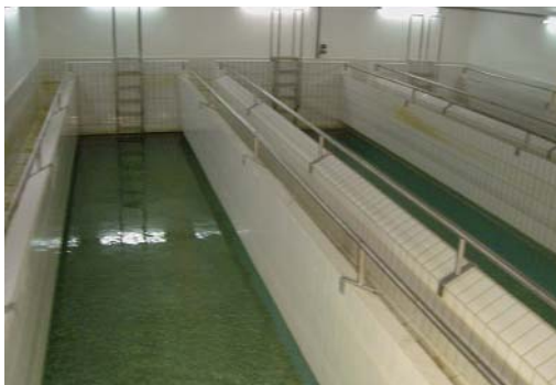
Figura 5.12: Vista de las celdas de una planta de calcita de flujo descendente.
