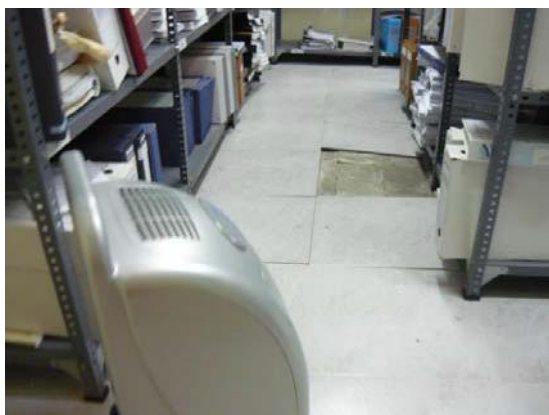
Foto 7: Vista Solería Archivo 1
