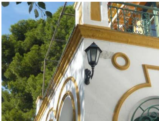
Foto 13: Fachada Exterior Ppal.
