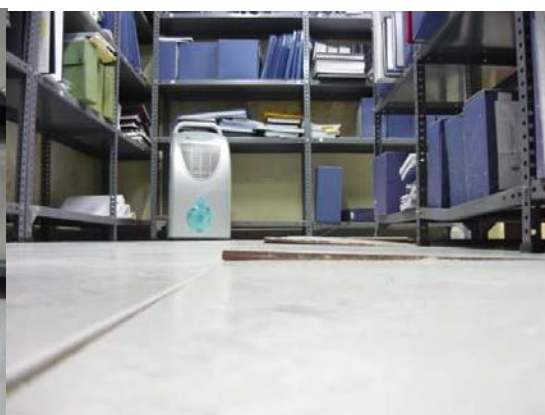
Foto 8: Vista Solería Archivo 2
