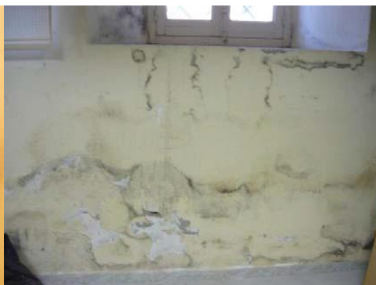
Foto 2: Muros perimetrales Semisótano
