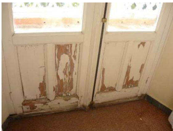
Foto 19: Interior Puerta Balconera P.1ª
