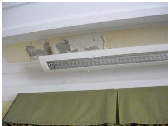
Foto 9: Techo bajo Terraza Despacho1
