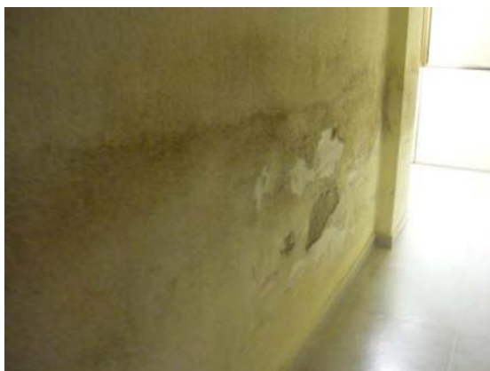
Foto 3: Pasillo Interior Semisótano
