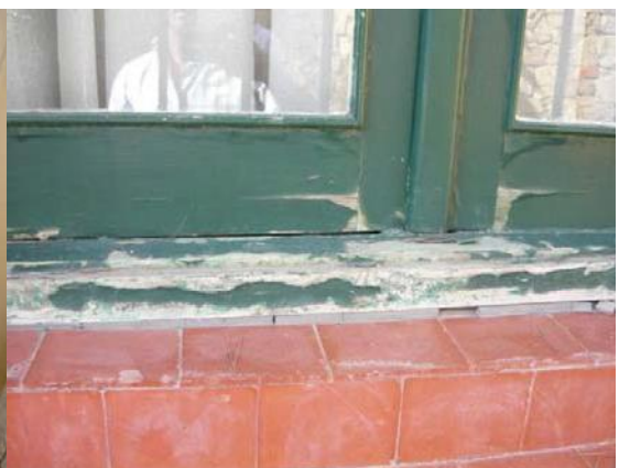
Foto 20: Exteriores ventanales P.Baja
