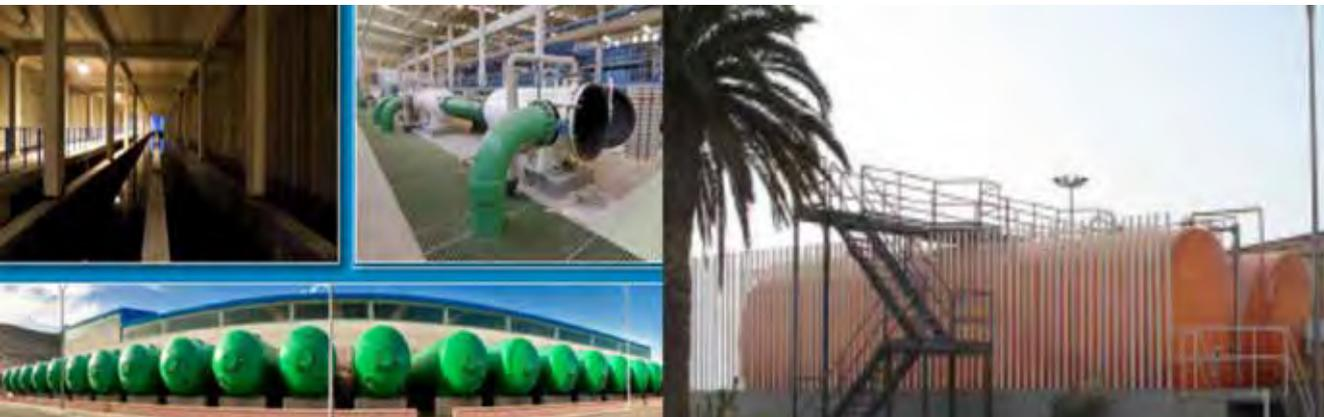
*Detalle de los elementos que componen el pretratamiento: canales desarenadores (izq. arriba), filtros de arena (izq. abajo), microfiltración (centro arriba) y depósitos de almacenaje de ácido sulfúrico e hipoclorito sódico (derecha).*
