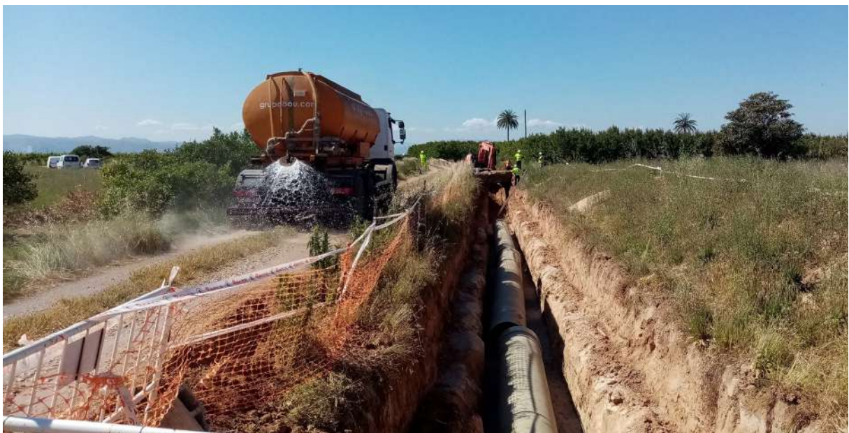
Riego en zonas de obra de los sectores 18 y 19 para la modernización de los regadíos de la Acequia Real del Júcar
