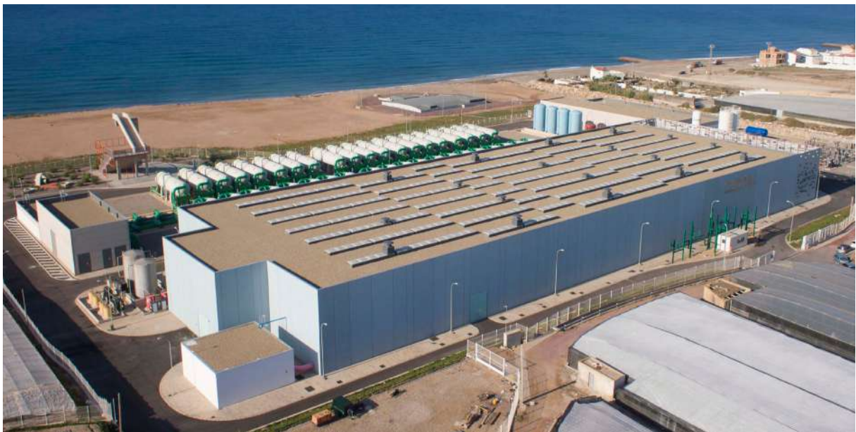
Desaladora de Campo de Dalías
