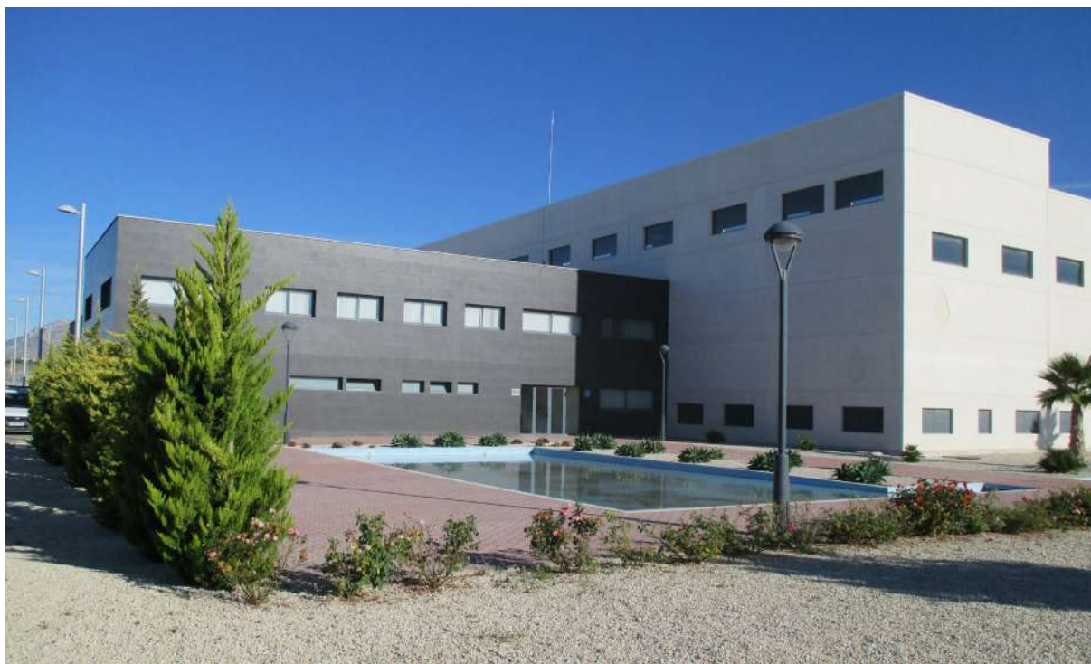
Desaladora de Mutxamel
