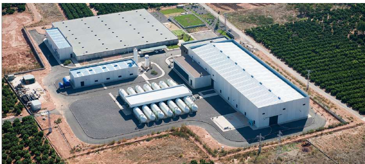
Desaladora de Moncofa
