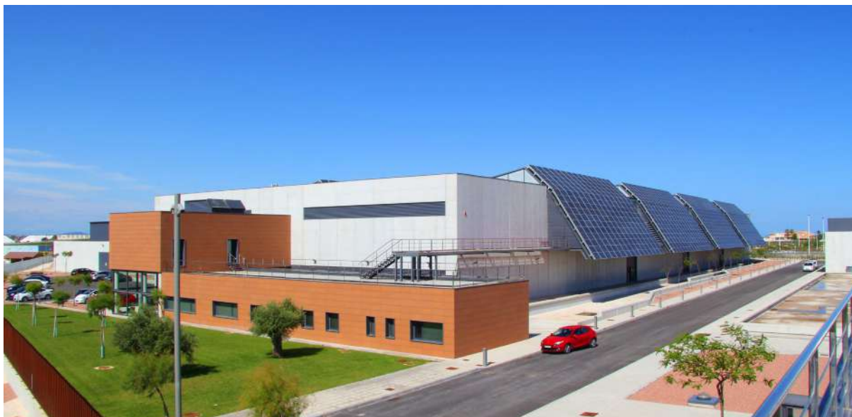
Desaladora de Torre Vieja
