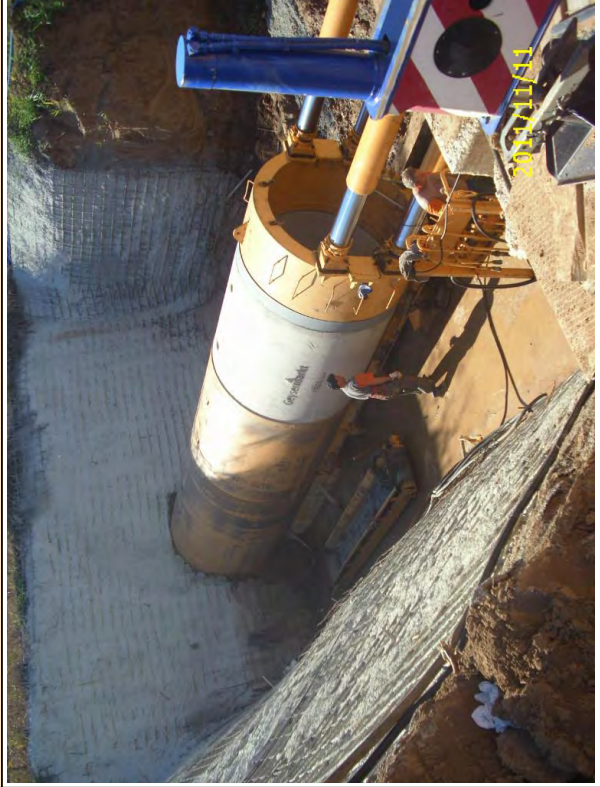
Foto 1. Hincia para el cruce bajo la autovía A-357 (nov 2011)
