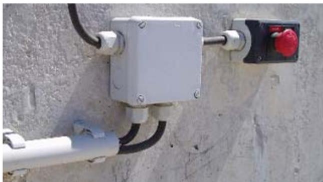
La alimentación de pantallas estancas, motores y otros equipos de las instalaciones húmedas se harán llevando cable en mangueras de 1KV hasta los mismos y entrando en ellos por medio de prensaestopas adecuados que permitan mantener la estanqueidad.
