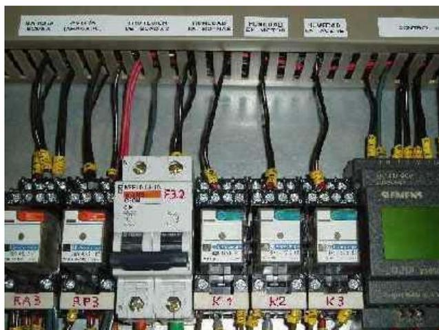
En equipos no preparados para este marcado se realizará con etiquetas de plástico blanco de 12mm de ancho con letras negras referencia 45013 para etiquetadora DYMO 1000 o similar, colocando dichas indicaciones sobre el equipo o sobre la canaleta superior al mismo.
