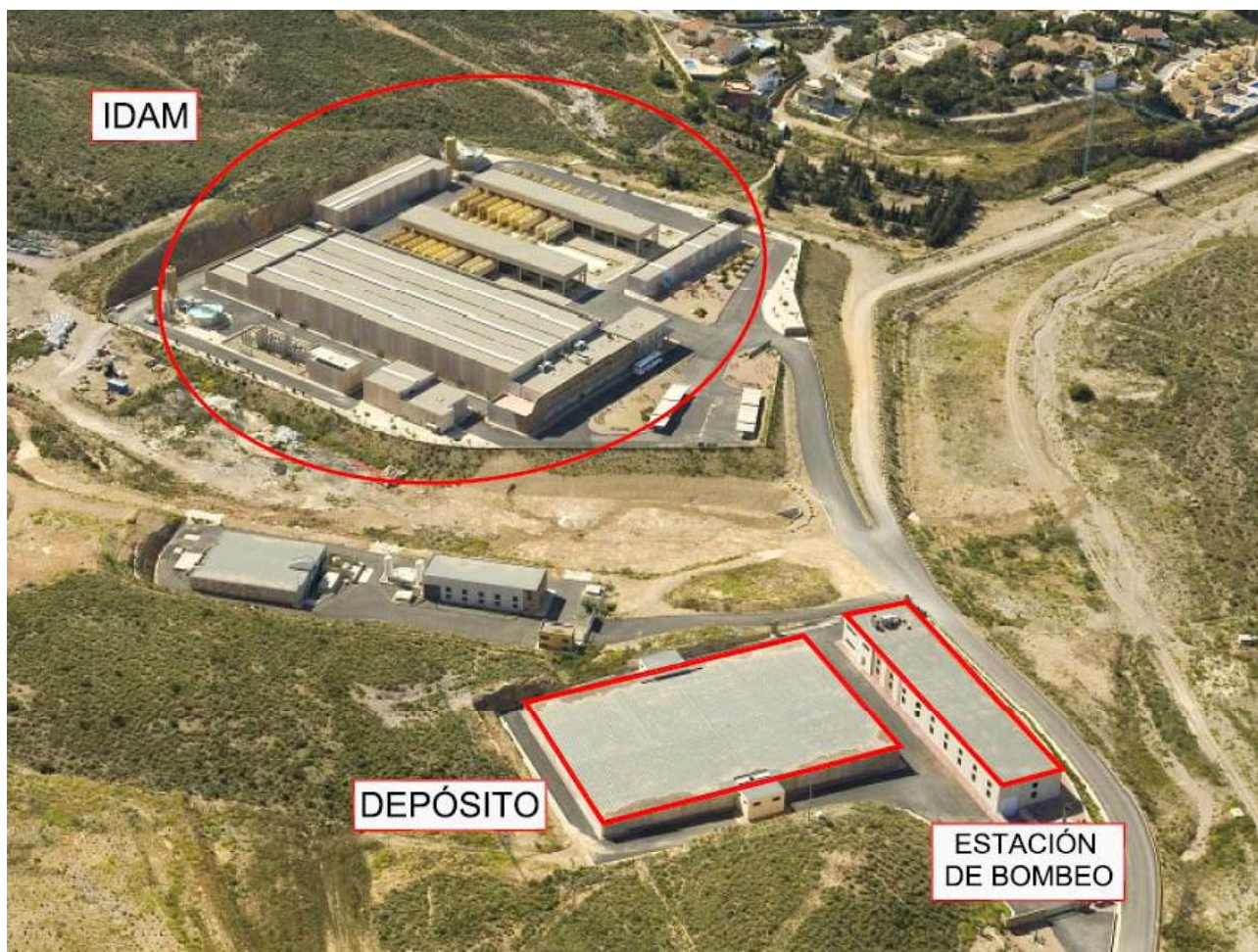
Panorámica de la IDAM de Valdelentisco y del depósito y bombeo a la red de distribución
