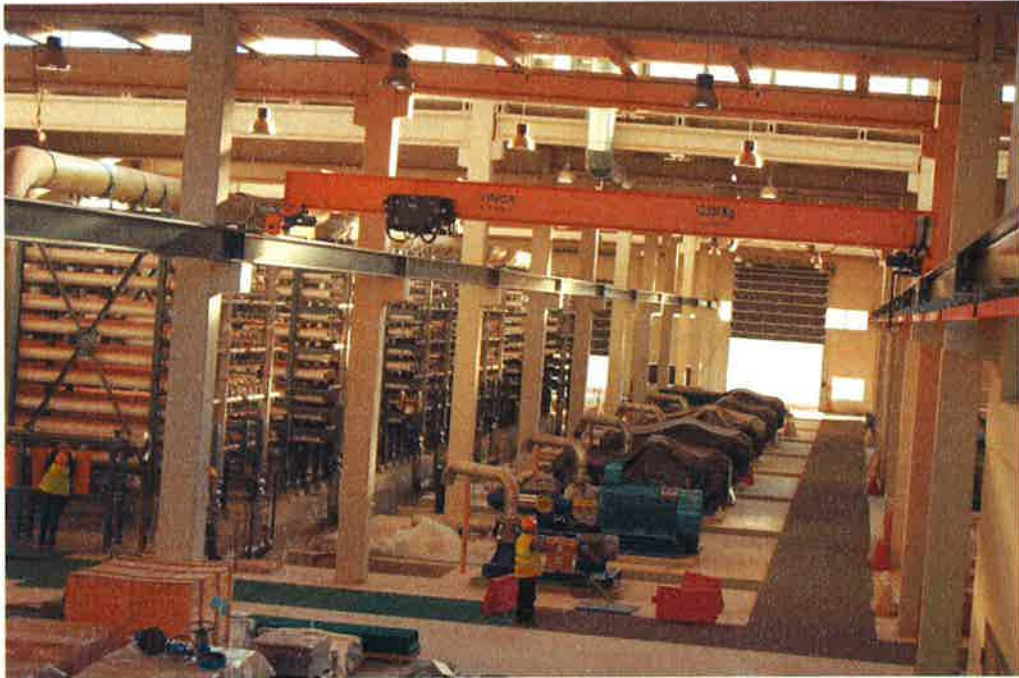
Nave de proceso
