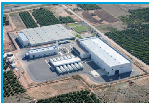
Desaladora de Moncofa (Castellón)
