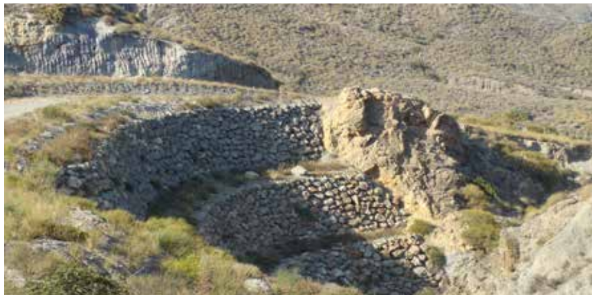
Talud restaurado con una escollera posteriormente revegetada.
