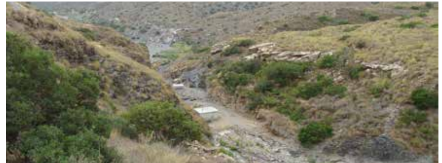
Rambla Cajón, por cuyo cauce discurre la tubería.
