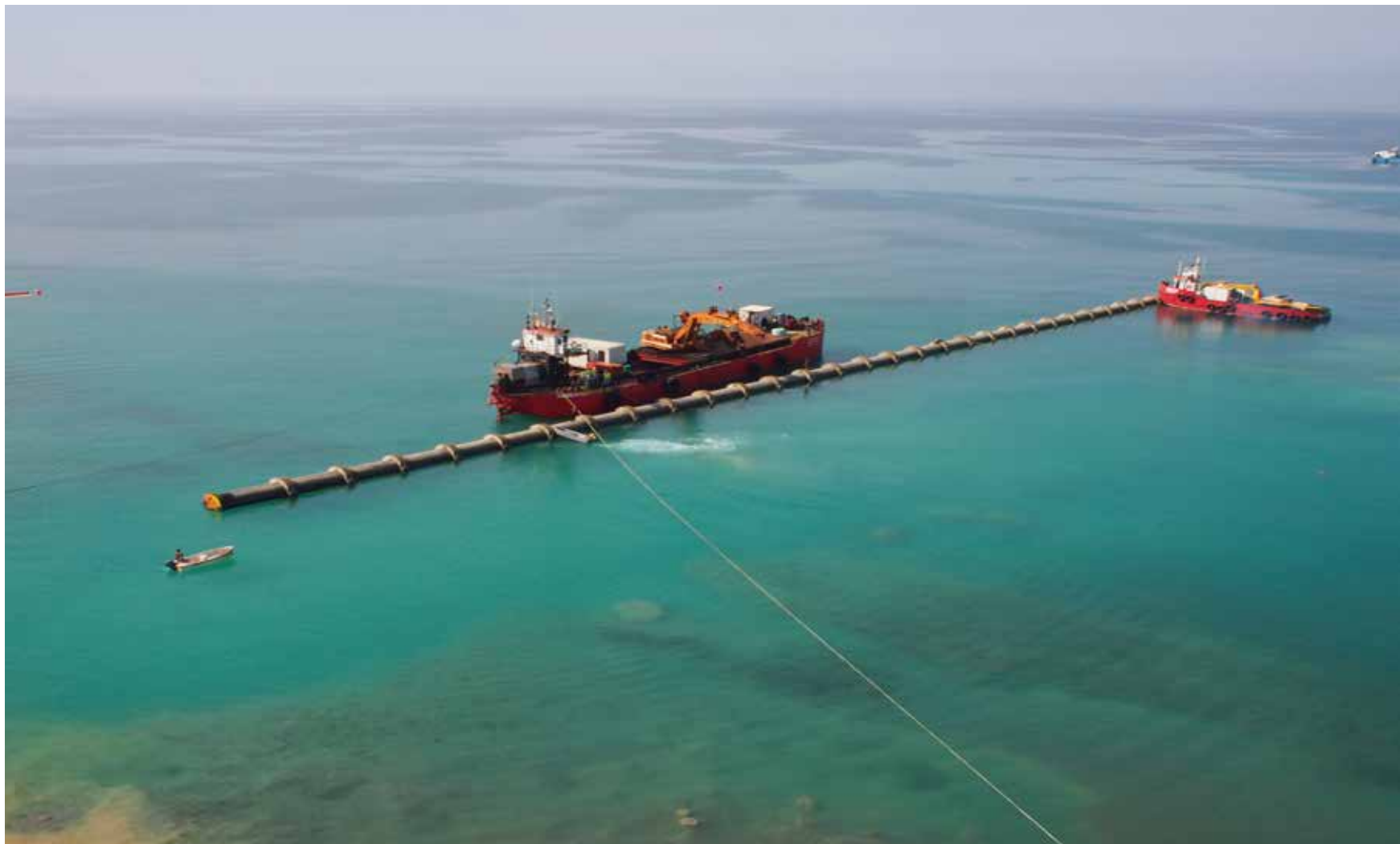
Trabajos de instalación de la conducción de toma de agua para una desaladora.
