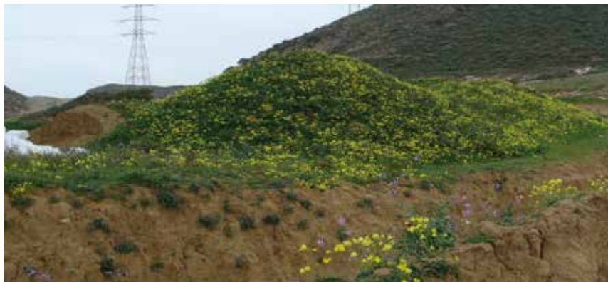
Acopio de la capa de tierra vegetal situada próxima a la zona de actuación.
