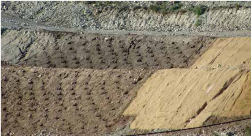
Pruebas de instalación de mantas vegetales de fibra de coco y esparto.
