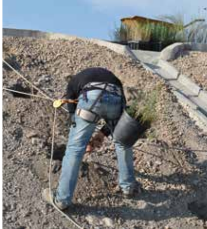
Plantación manual en taludes de elevada pendiente.
