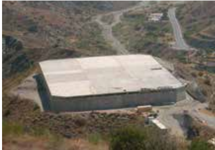
Depósito de agua de Sopalmo.
