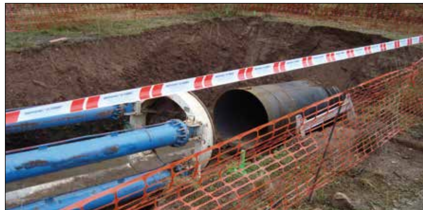
Obras de entubación.
