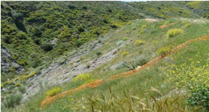
Revegetación de taludes utilizando especies autóctonas.
