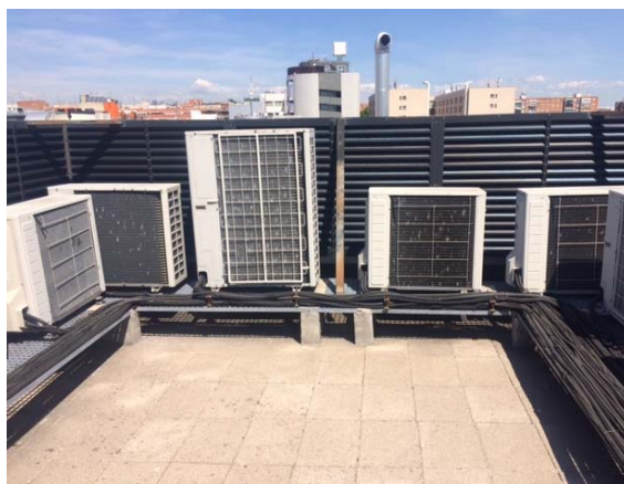
Foto 19 y 20.- Equipos de frio del edificio
